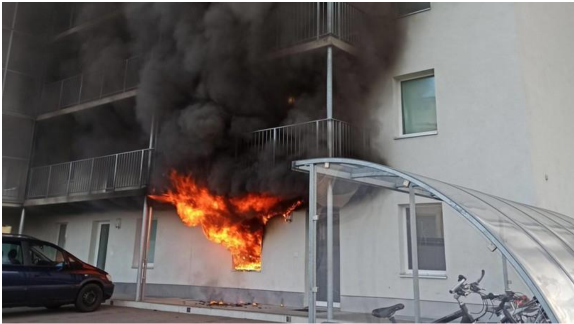
Die Flammen schlagen aus einem Fenster der Wohnung. © Twitter/Kapo AG
